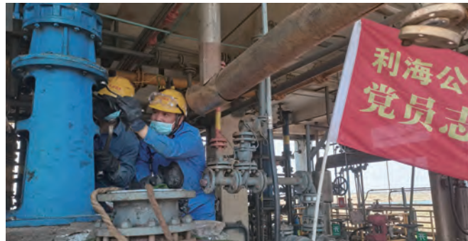
连日来,利海化工公司党总支广泛深入开展“党旗飘在一线、堡垒筑在一线、党员冲在一线”行动,成立党员先锋队、志愿服务队,充分发挥党员先锋模范作用,确保疫情期间安全生产形势稳定。图为党员抢修苯甲醛装置水解釜搅拌机。(顾孟 曹加余)
