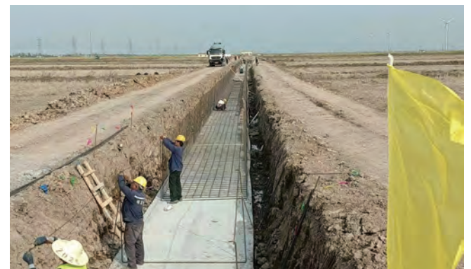
连日来,灌西明威农业公司按照旱、涝、渍和盐碱综合治理的要求,40KM高标准农田田间灌排渠系统建设如火如荼,大型机械来回穿梭,工人们修筑渠坝,一派繁忙景象,高效推进高标准农田项目建设,确保如期完成建设任务。(许东彦 杨加军)
