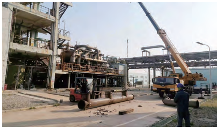
凯实金桥公司加大环保设施维护工作,投入近20万元对污水、尾气在线检测系统及机器核准和维护,进一步提高装置生产率和产业竞争力。图为利用停车时间对氯化苈装置尾气机组进行检修。(匡洪志)
